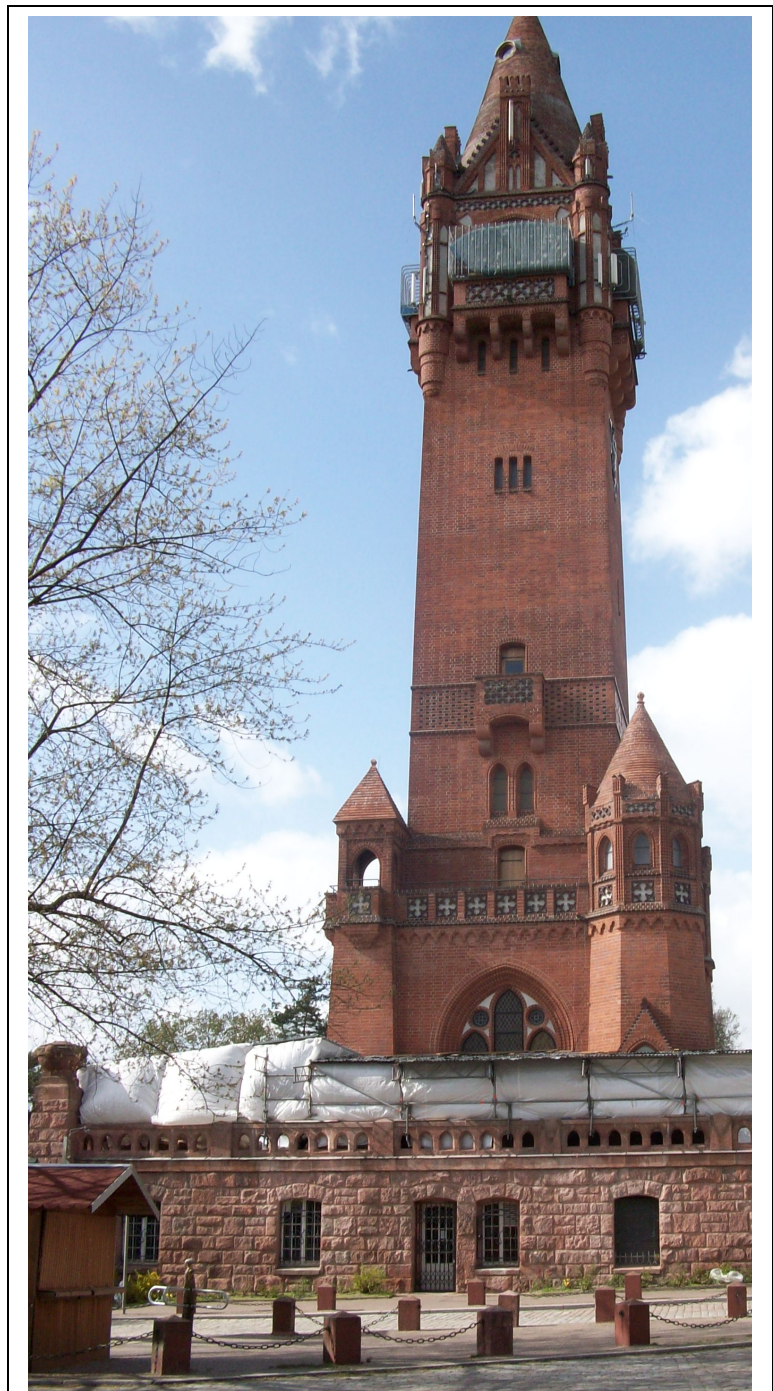
2011 Renovierungsarbeiten am Turm
